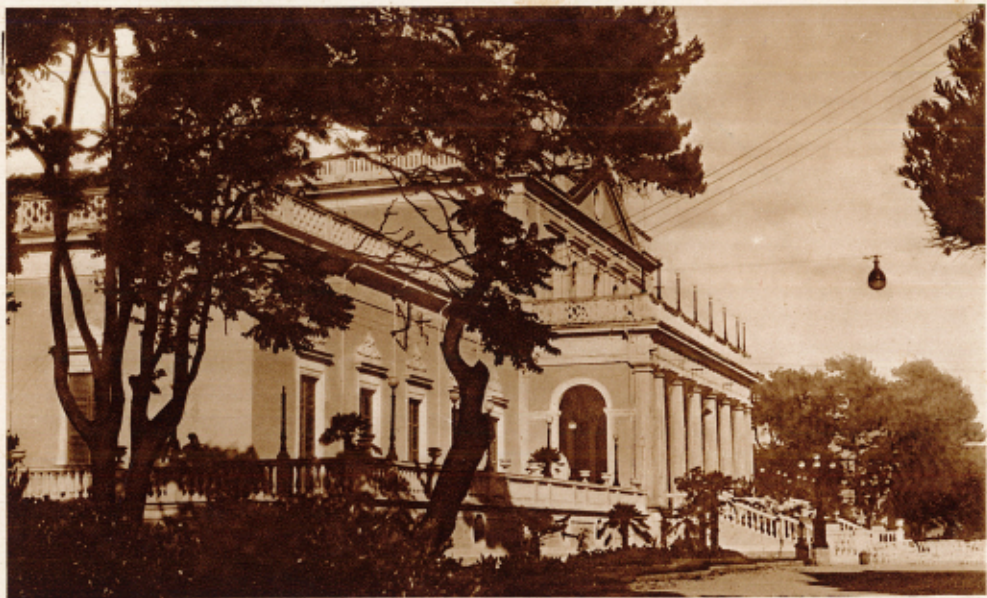
RIMINI - Kursaal - lato a monte
